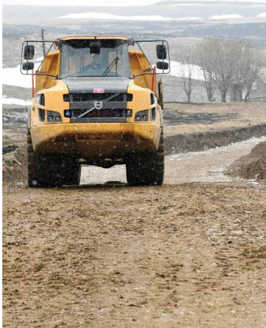
Radovi na trasi ka VE Gvozd
