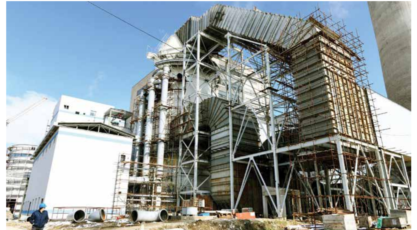
Građevinski radovi na TE Pljevlja se privode kraju
