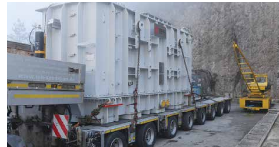
Нови трансформатор у ХЕ Пива
