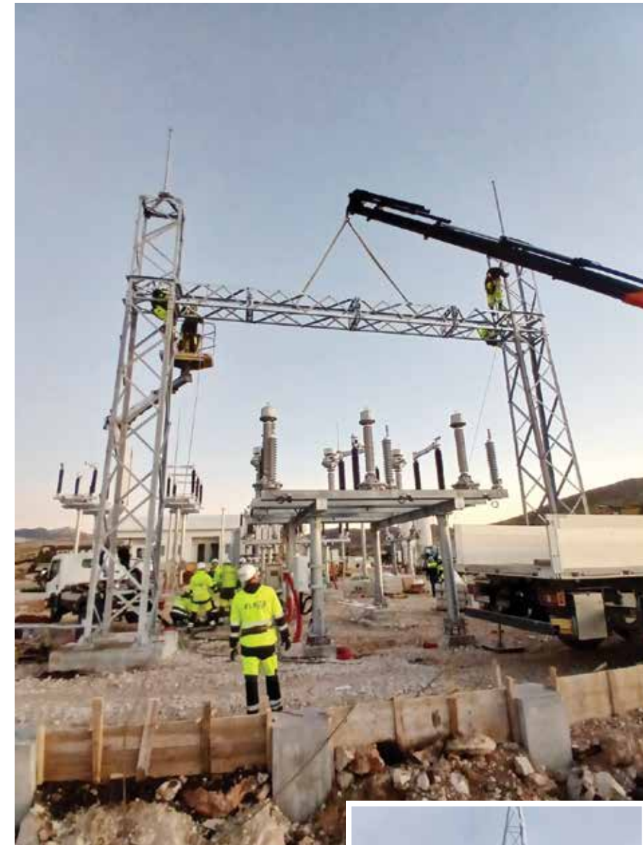
Podizanje portala u TS Gvozd - Foto: Privatna arhiva
