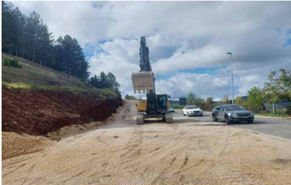
Радови на траси топловода
