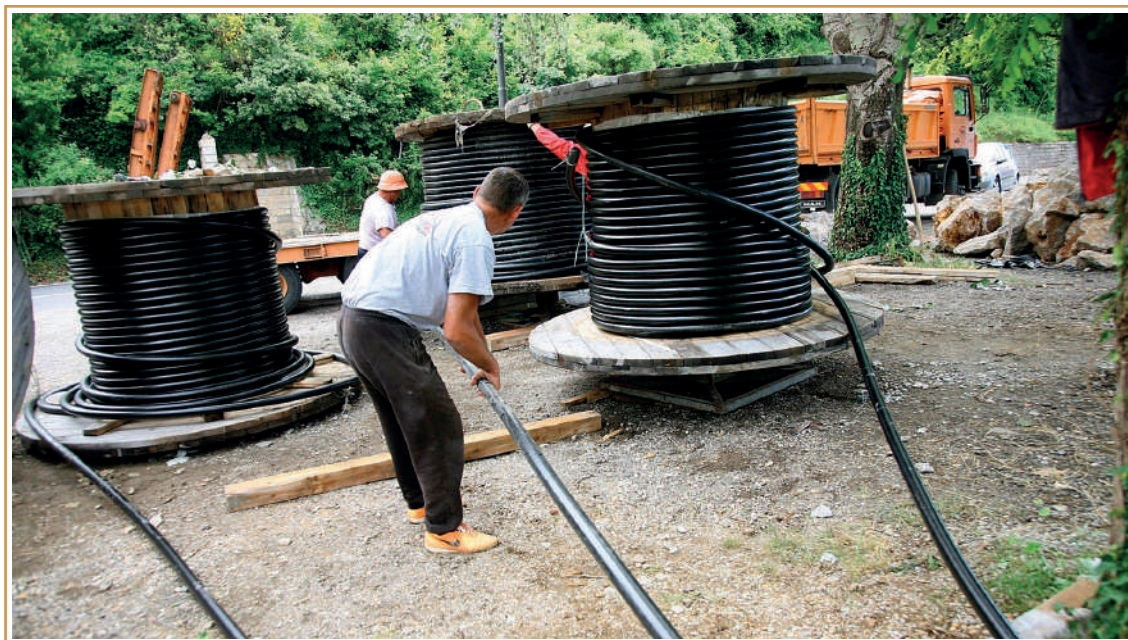
Postavljanje podvodnog kabla, maj 2015. godine
