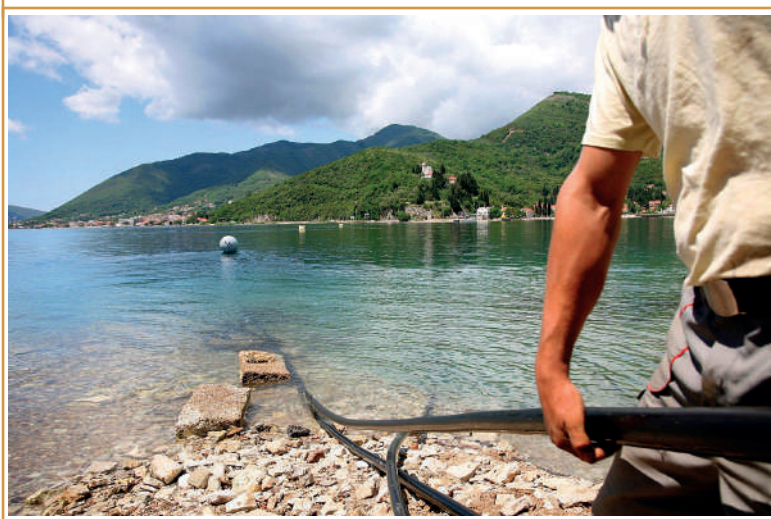
Postavljanje podvodnog kabla, maj 2015. godine
