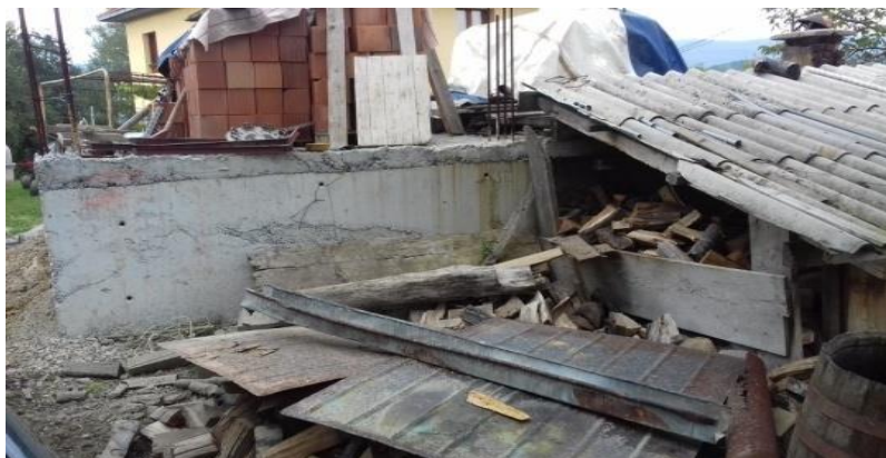
Dogradnja – betonski dio+drveni dio kosi krov
