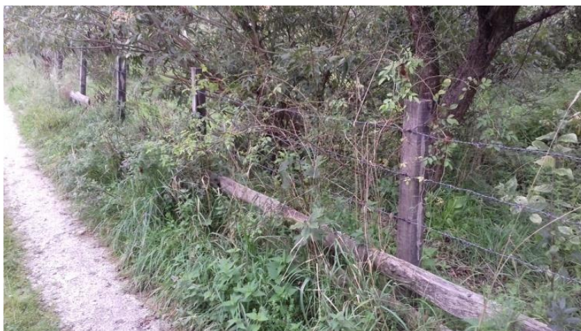
8. Ograda od parmaka na drvenom kolju, l=46 m
