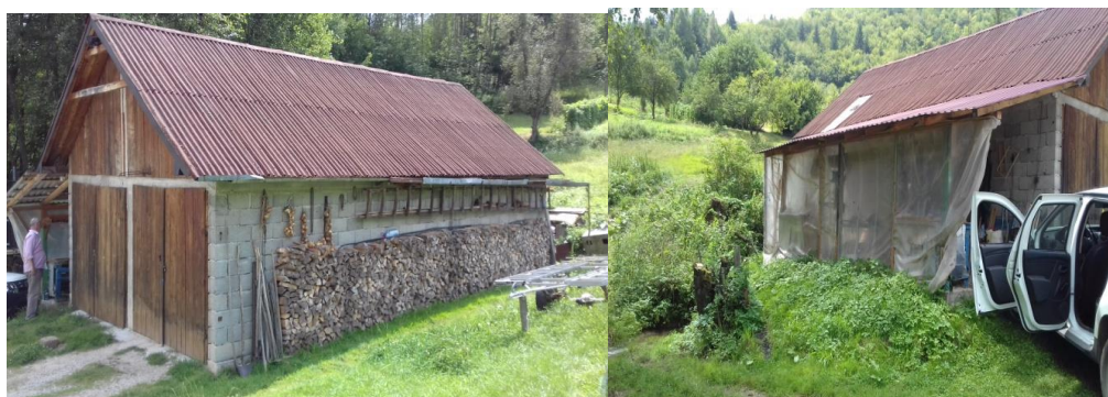
Garaža - sjeverozapadno i jugoistočno
