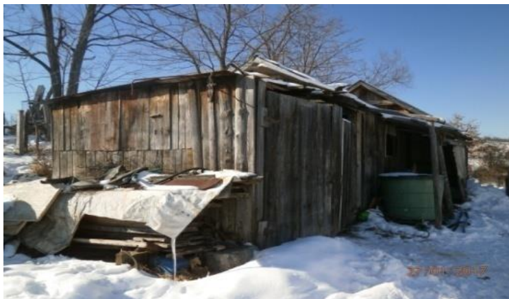
Drvena šupa i kačara istočno od garaže
