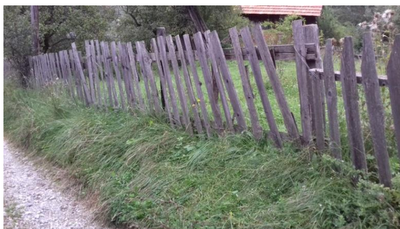
8. Ograda od parmaka na drvenom kolju, l=46 m
