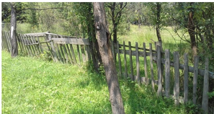
9. Ograda od 4 reda baskija i letva po vrhu, l=80 m
