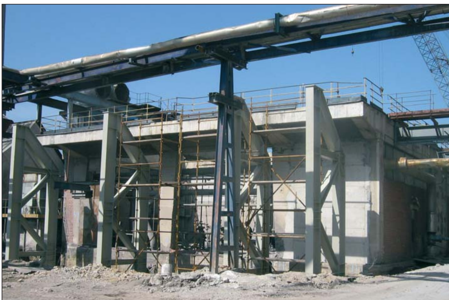
Темељи за ново електрофилтерско постројење
