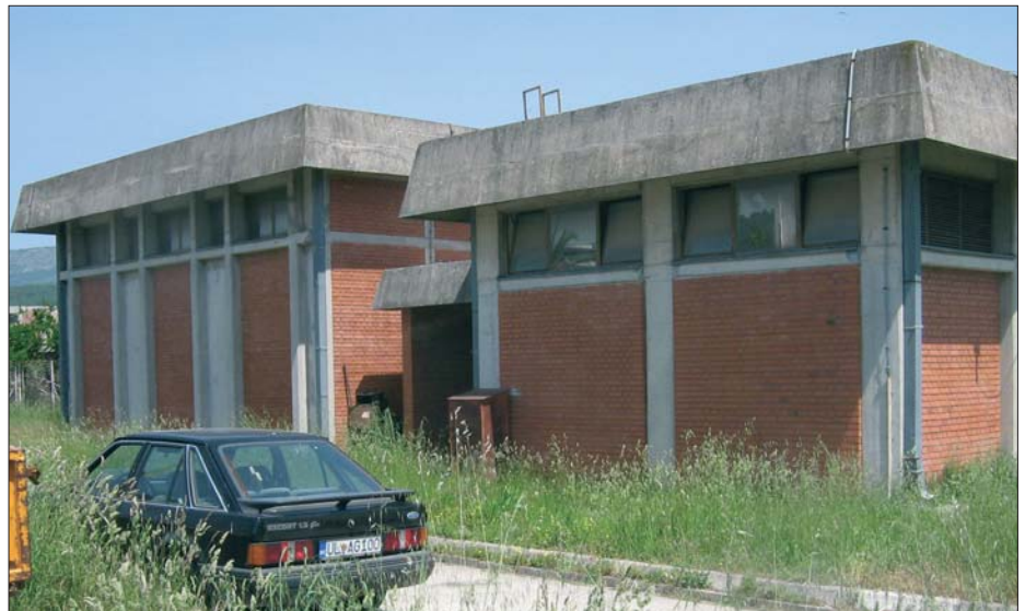
ТС 35/10 kV Град
