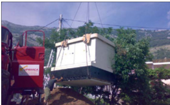
Монтажа ТС 10/0,4 kV Чањ
