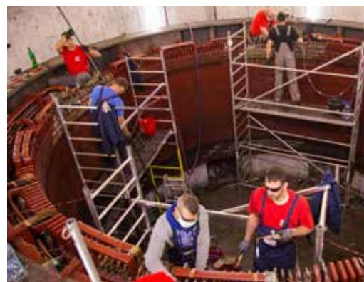
ti (BUMP test), ispitivanje izolacije između limova statorskog paketa indukcijom od 1T, mjerjenje ugla gubitaka po fazi, mjerjenje parcijalnih pražnjenja statorskog paketa, mjerjenje struja odvoda statorskog paketa pojedinih faza pri linearном porastu napona, ispitivanje izolacije namota statora visokim naizmjeničnim naponom sa 1,3Un.
