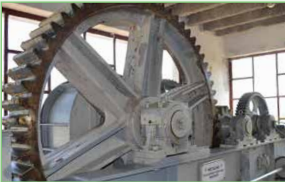
Postrojenja prelivnih klapni na zatvaračnici "Vrtac"
