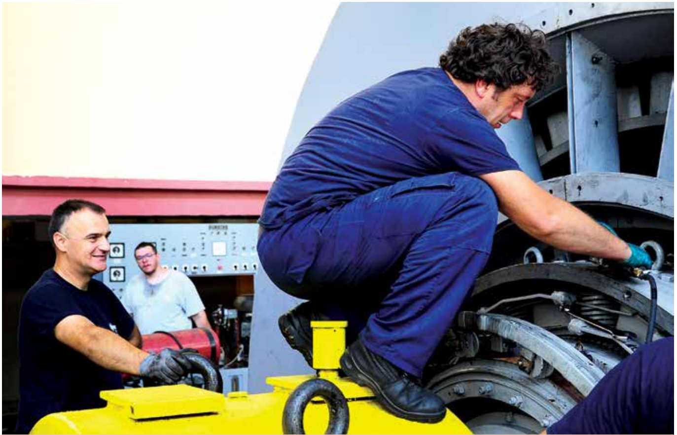
Детаљ са ремонта
