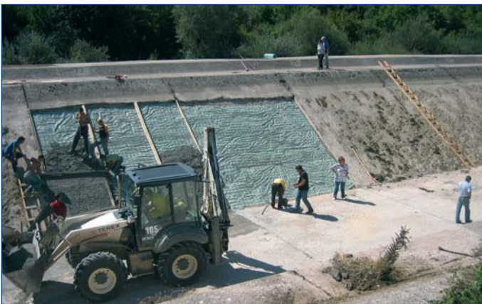
Замјена бетонске облоге у каналу Зета 1
