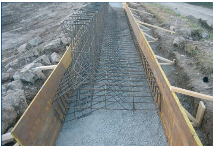
Уградња арматуре АБ зида на базену
