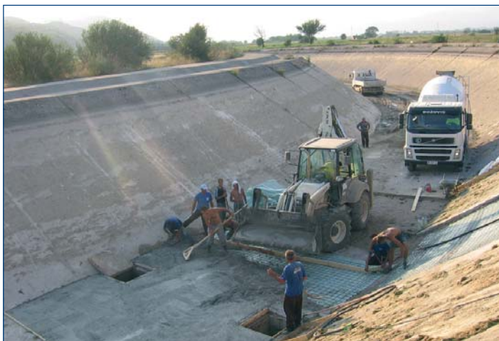
Замјена бетонске облоге у каналу Зета I
