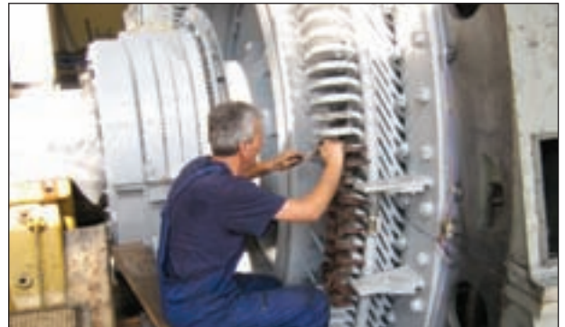
Радник МГ сервиса: Ремонт агрегата АЗ
