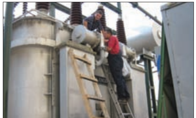
Радници “Електроисток - Изградња” на послу у РП 110 kV
