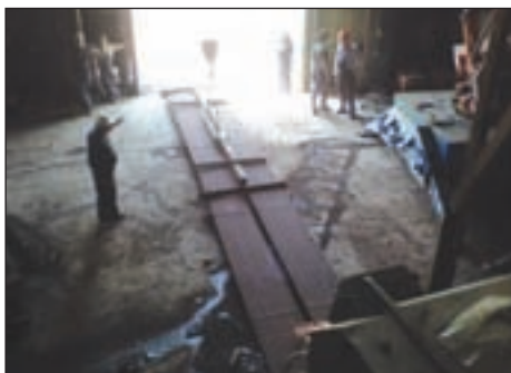
Детаљ са котла
