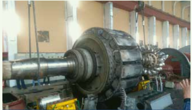
Revitalizacija generatora G4 - Demontaža rotora generatora sa osovinom
