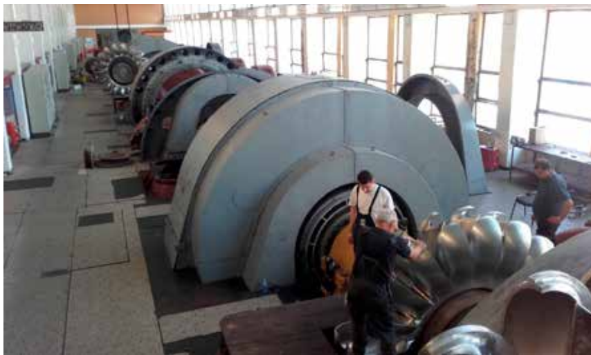
Izvođenje radova na pregledu i sanaciji turbinske opreme
