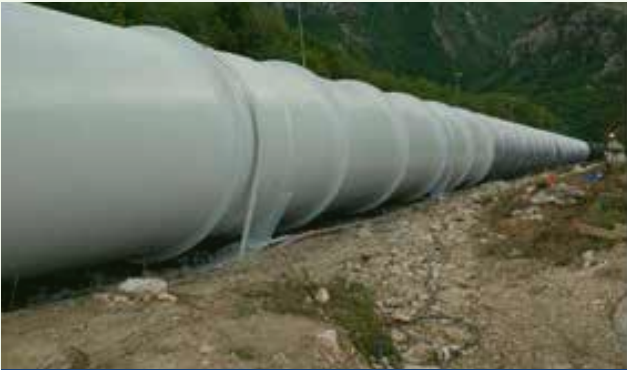
Završni premaz na cjevovodu III
