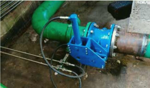
Novi leptirasti zatvarač sa novim hidrauličkim razvodom na zatvaračnici Povija
