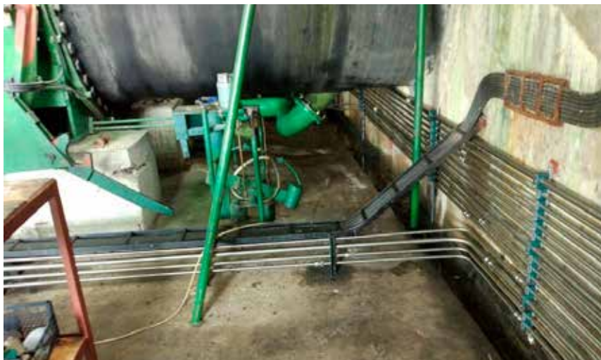
Novi hidraulički razvod od nerđajućeg čelika na zatvaračnici Povija
