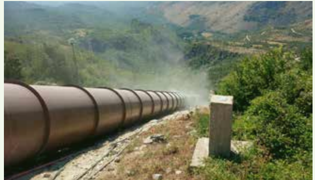
Nanošenje osnovnog premaza na cjevovod III
