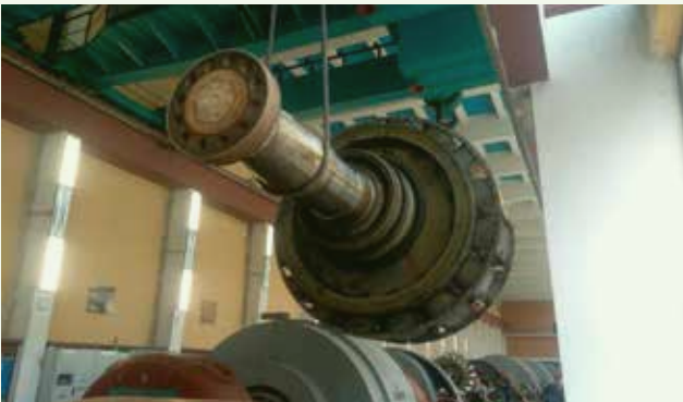
Revitalizacija G4 - Transport rotora
