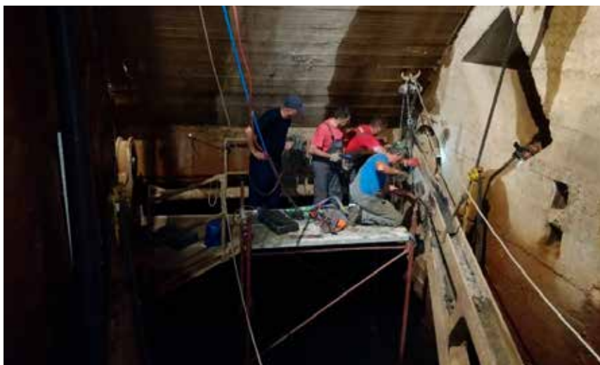
Montaža ležaja segmentnog zatvarača na zatvaračnici Slano
