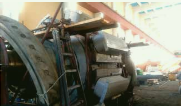
Montaža preizolovanih polova
