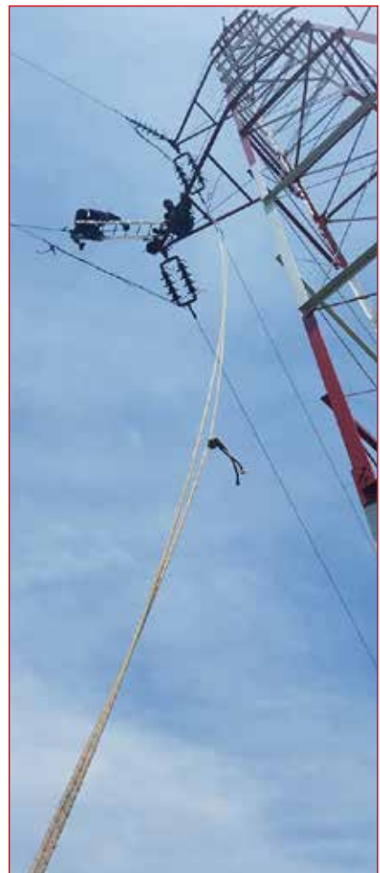
Sanacija prekida izolatorskog lanca na DV 35kV Ponari Virpazar
