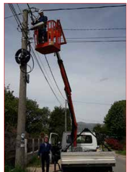
Rekonstrukcija NN mreže Vidrovan
