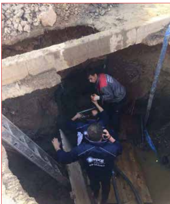
Sanacija kvara na 10kV kablu u Ulcinju
