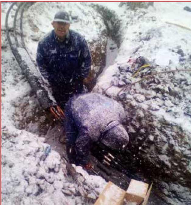
Ranko Kažić i Puniša Jovanović u ekstremnim vremenskim uslovima vrše popravku 10kV kabla u rasklopištu Veruša“
