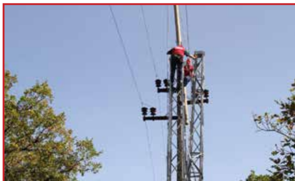
Težak posao dizanja zateznog stuba: Vladimir Stešević i Đole Mitrić obojica sa po 20 godina monterskog staža
