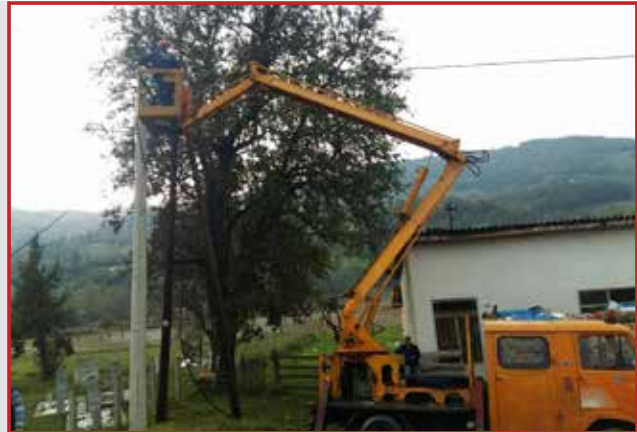
Rekonstrukcija i priprema trafostanice za ugradnju novih brojila
