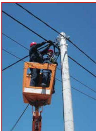
Rekonstrukcija NN mreže
