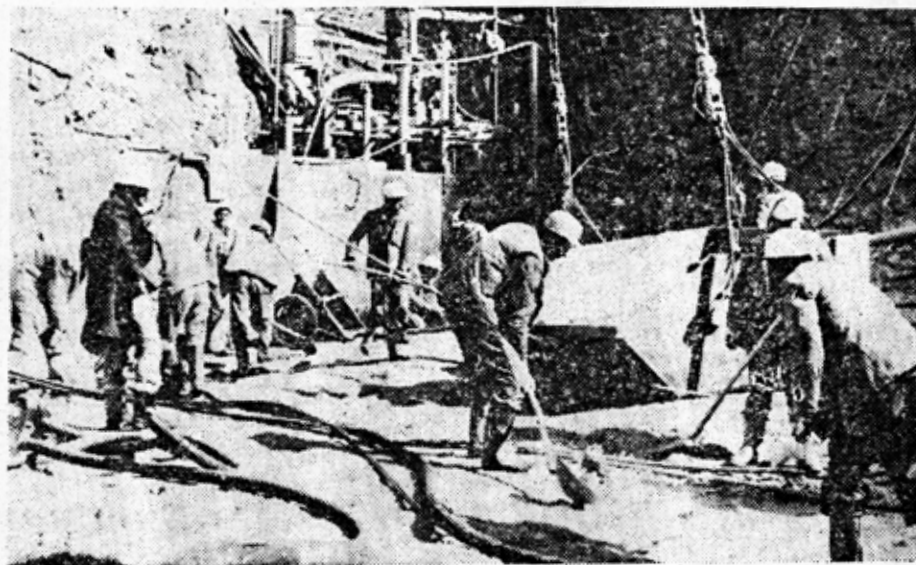
ПРИПРЕМА БЕТОНА ЗА ТЕМЕЉЕ БРАНЕ ХЕ „МРАТИЊЕ“
