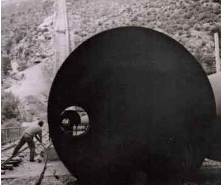
Radovi na Hidroelektrani „Perućica”
