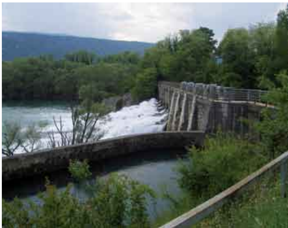
Brana hidrocentrale “Slap Zete”
